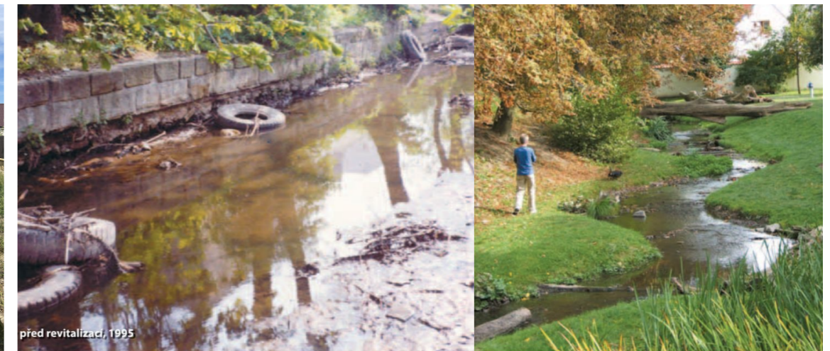
Obrázek 2-Referenční řešení Vytvořené složené koryto v Chrudimi
