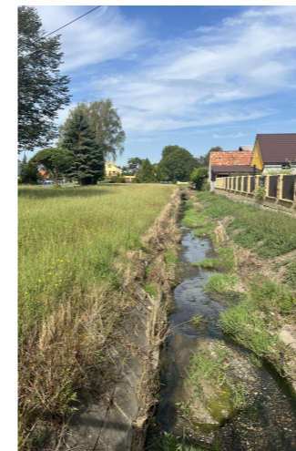
Obrázek 1- Stávající stav Napřimené opevnění koryta Petkovského potoka.
