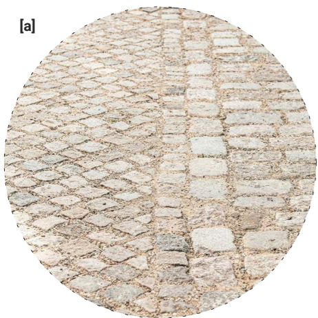
Změna materiálu vozovky na kamennou dlažbu
