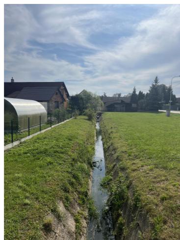
Obrázek 6- Stávající stav Napřímené opevněné koryto.
