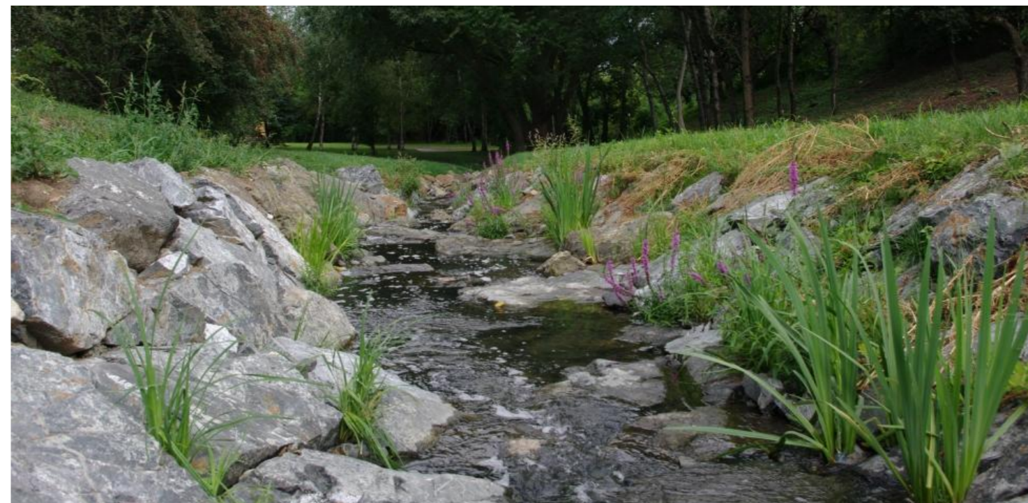
Obrázek 10 - Referenční řešení: Nahrazení betonového opevnění kameny, které podporují vrůstání vegetace, mírnější svahování břehů koryta
