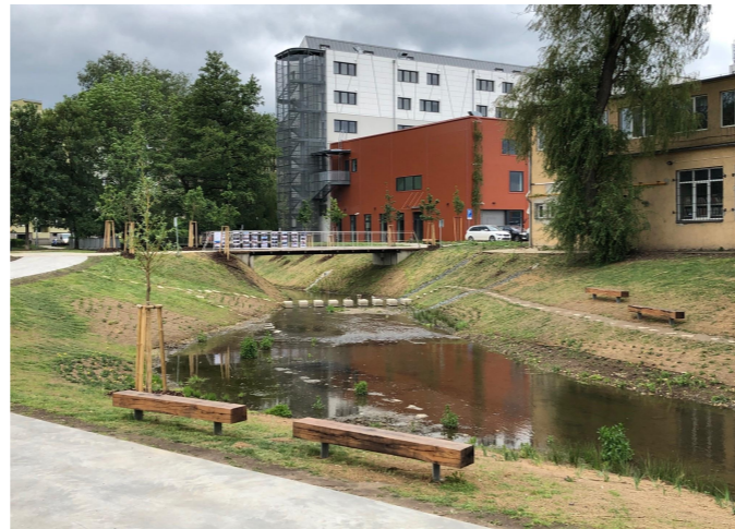
Obrázek 4- Referenční řešení Vytvoření tůňky v nárazovém břehu vodního toku
