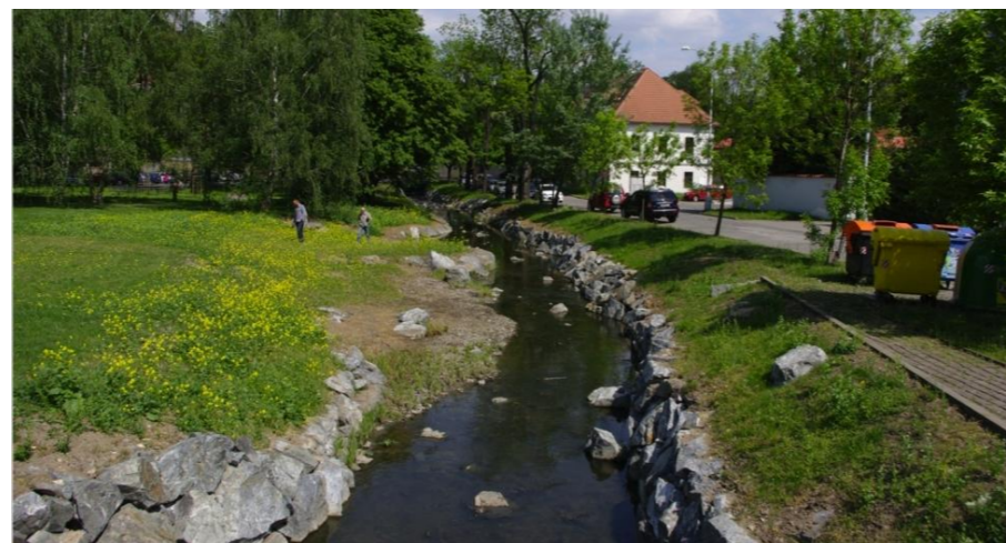
Obrázek 7- Referenční řešení Jednostranné rozvolnění koryta vodního toku.
